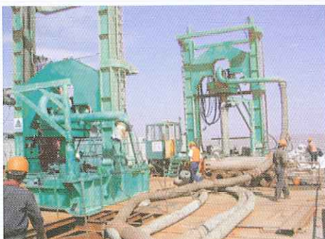
杭州湾跨海大桥施工现场
