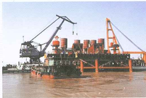
金塘大桥施工现场
